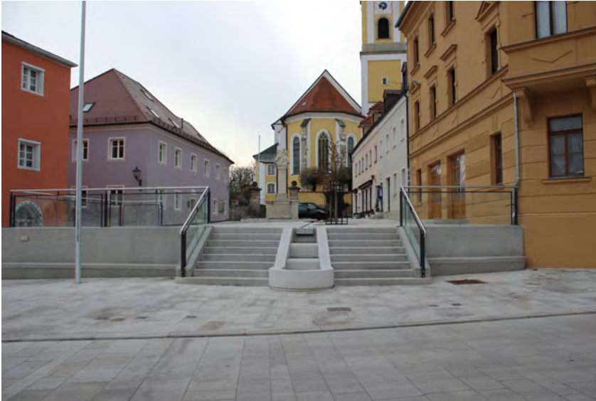
Kriegerdenkmal nach dem Umbau
