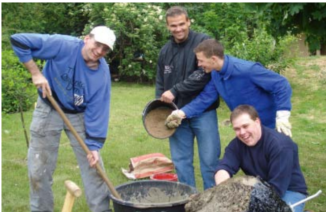
Abb. 7: Einsatz mit viel Engagement – vier Azubis beim Bau einer Wippe für eine Kita im Rahmen von ESSEN.aktiv
